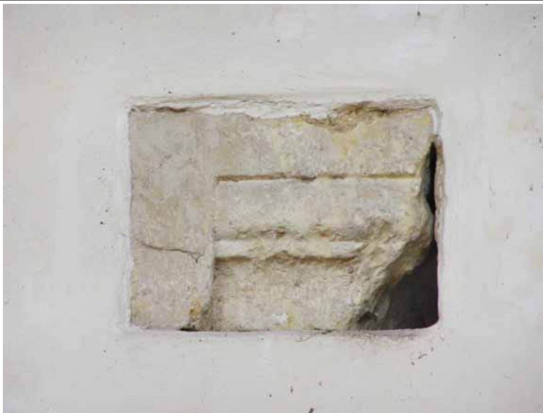
Odhalený románský prvek druhotně zalděný do severního zdiva presbytáře. Foto: Jan Koloc, 2009.
