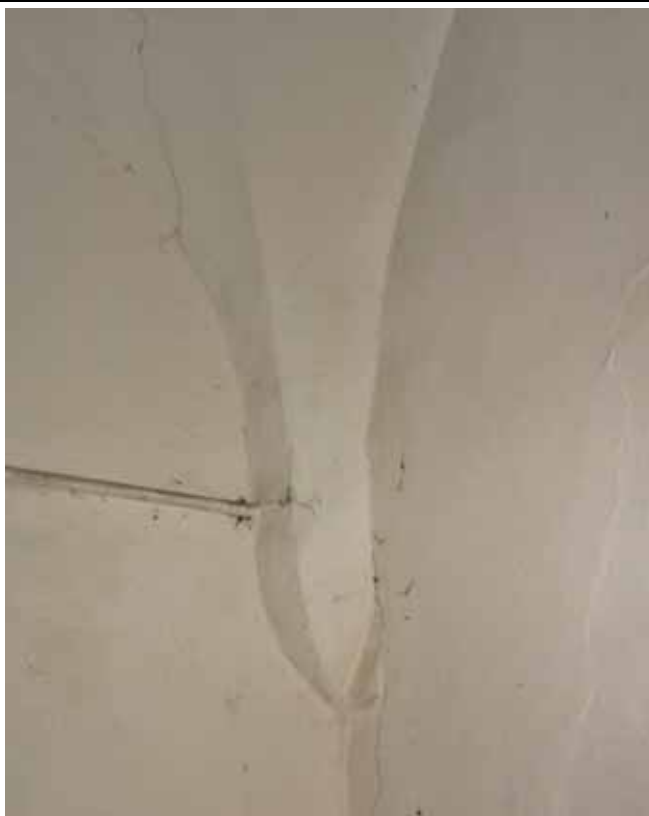
Jihozápadní výběh klenby prvního patra věže. Foto: Lucie Radová, 2009.
