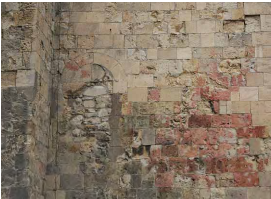
Čelní pohled na severní část věže na úrovni prvního patra se zřetelným červeným zabarvením opukového kamen po působení žáru a zazděným románským portálem do prvního patra věže. Foto: Lucie Radová, 2009.
