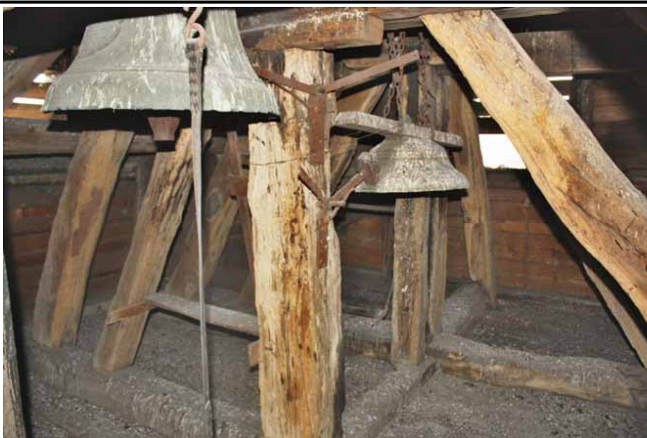
Zvonová stolice v podstřeší věže. Foto: Lucie Radová, 2009.
