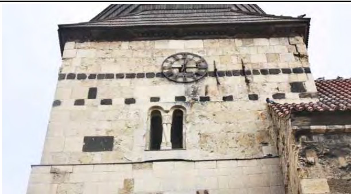
Jižní průčelí věže na úrovni jejího třetího patra s pásem odlišně zbarvených kamenů a sdruženým okenním otvorem. Foto: Foto: Lucie Radová, 2009.
