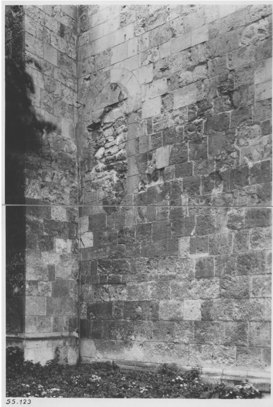
Severní průčelí věže v pohledu od severozápadu. Foto: 1952, sbírka negativů GŘ NPÚ, sign. N055123.
