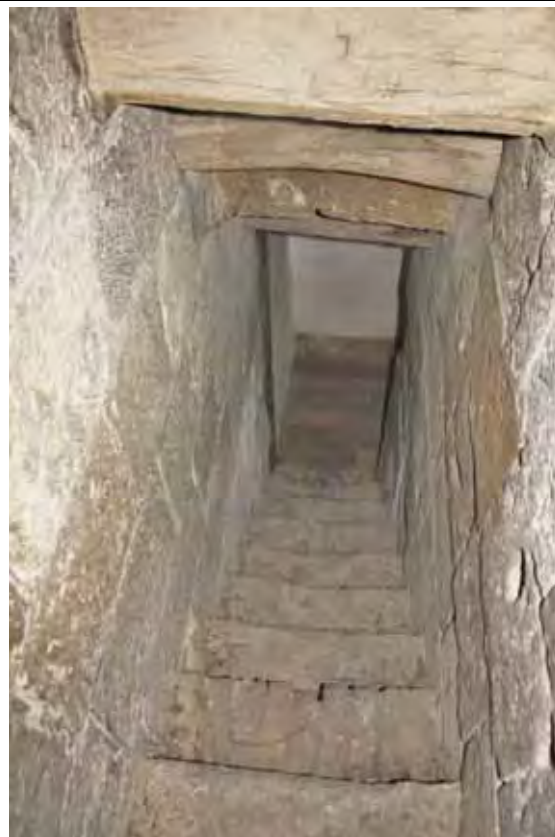
Spodní rameno schodiště v tloušťce zdi mezi prvním a druhým patrem věže v pohledu od západu. Foto: Lucie Radová, 2009.
