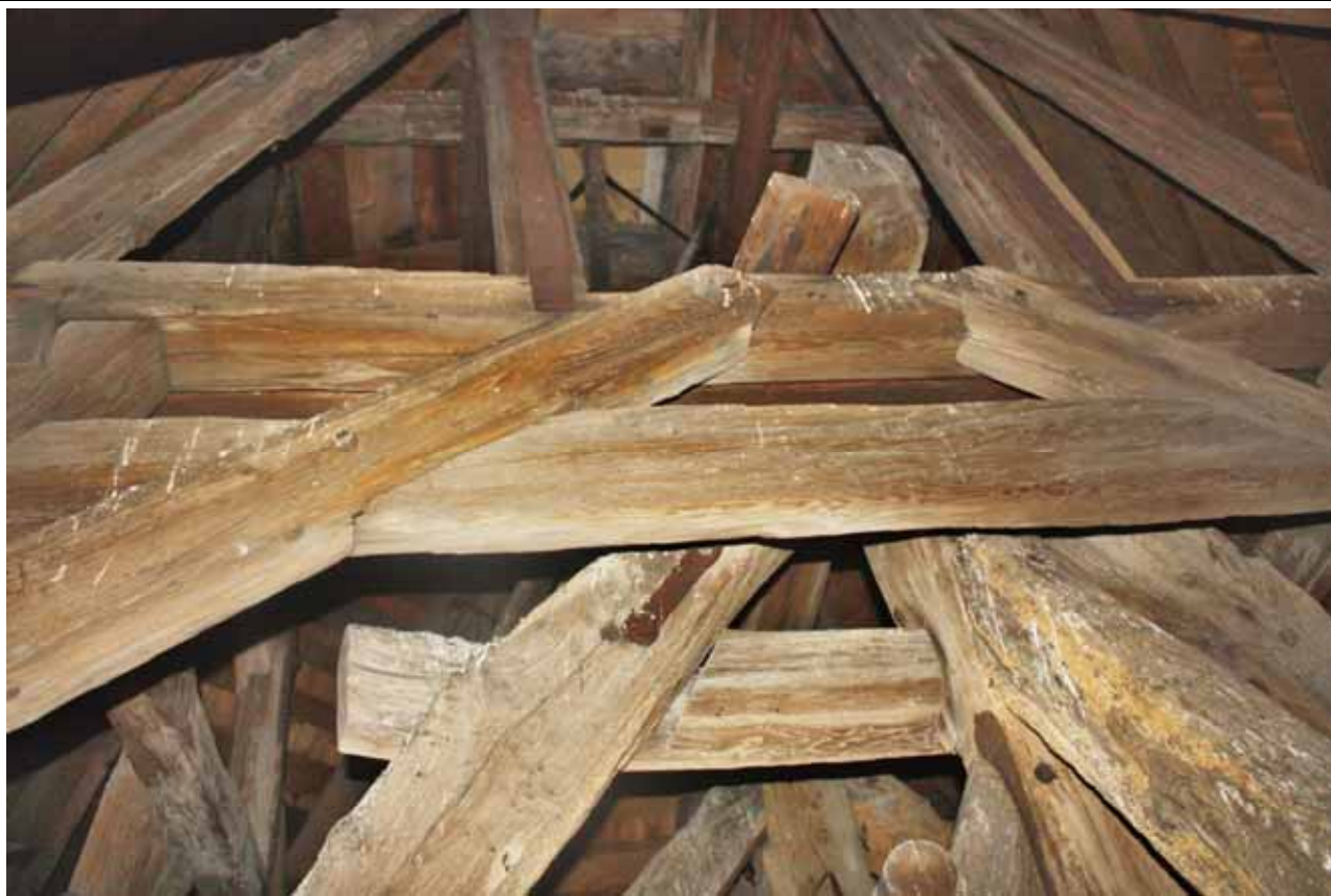
Ležatá stolice krovu věže. Foto: Lucie Radová, 2009.
