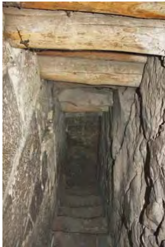
Horní rameno schodiště v tloušťce zdi mezi prvním a druhým patrem věže v pohledu od jihu. Foto: Lucie Radová, 2009.
