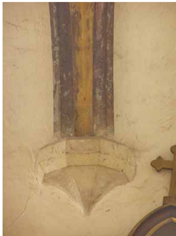
Detail klenební konzole presbytáře. Foto: Jan Koloc, 2009.
