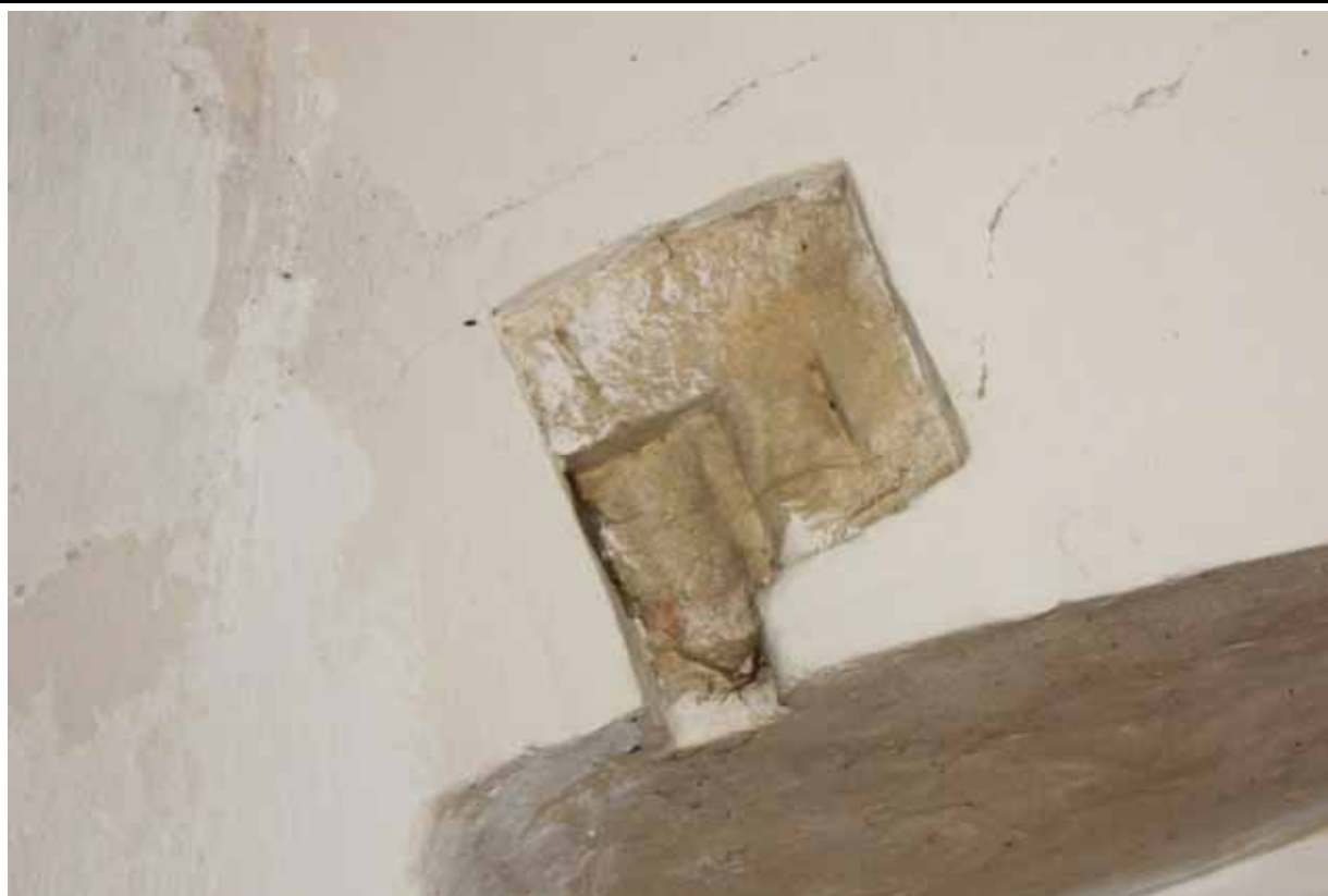
Odhalený románský prvek druhotně zazděný do záklenku dveřní niky vstupu z presbytáře do sakristie. Foto: Lucie Radová, 2009.
