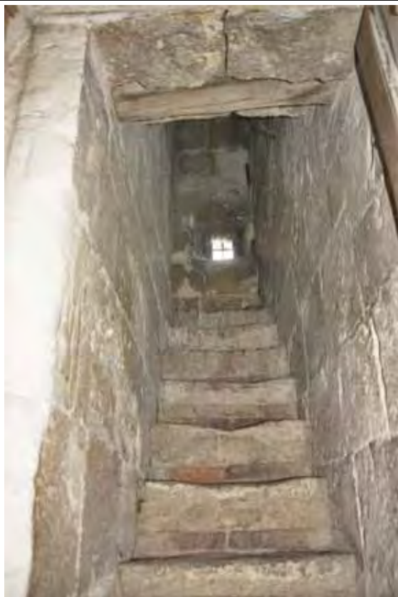
Spodní rameno schodiště v tloušťce zdi mezi prvním a druhým patrem věže v pohledu od východu. Foto: Lucie Radová, 2009.
