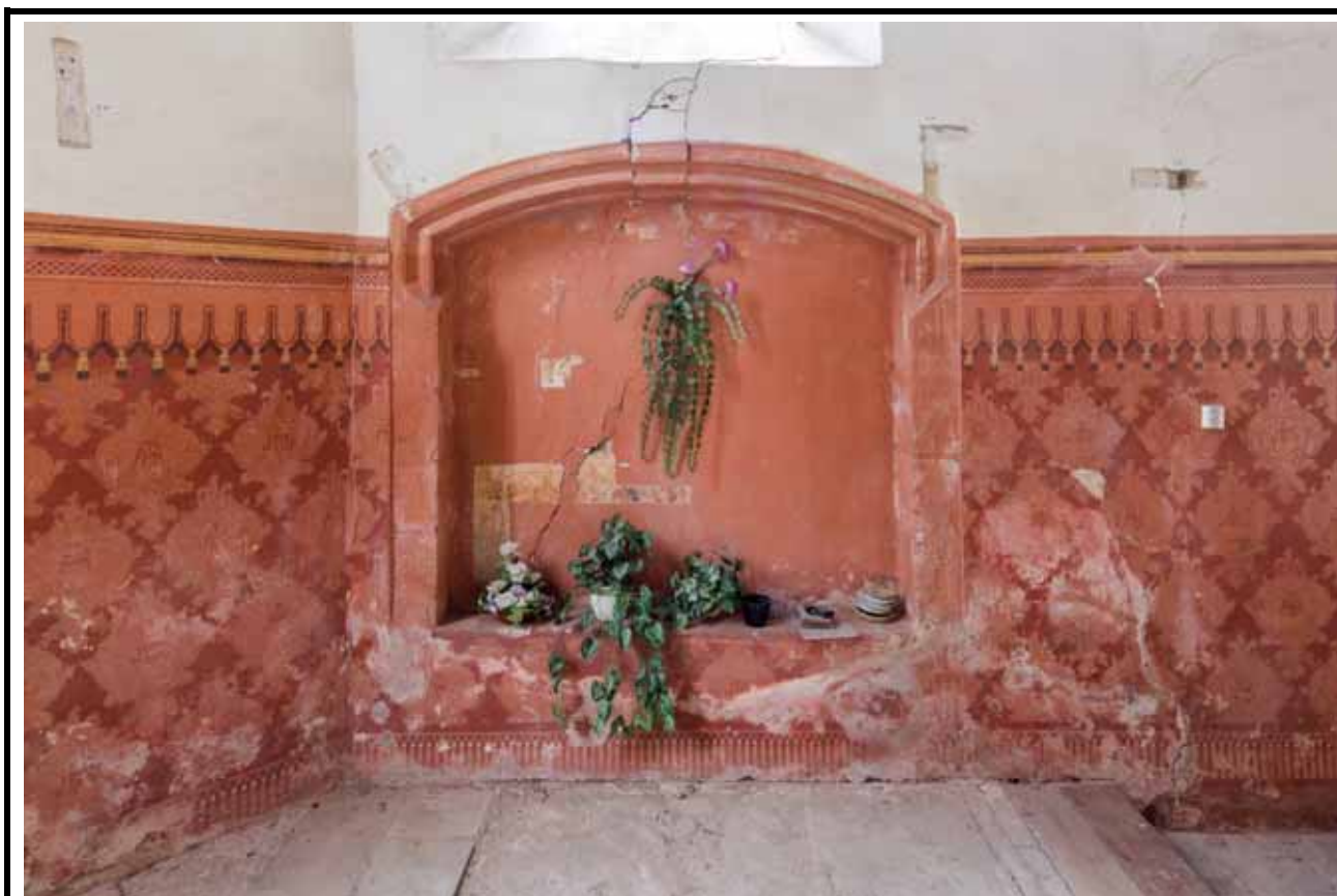
Čelní pohled na sedile. Foto: Marta Pavlíková, 2021.
