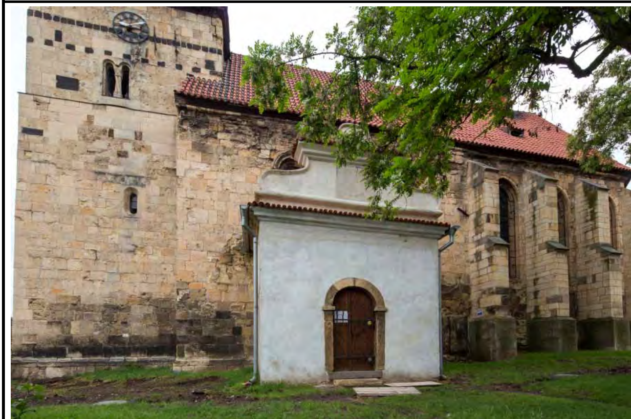
Jižní průčelí v pohledu od jihozápadu. Foto: Marta Pavlíková, 2014.
