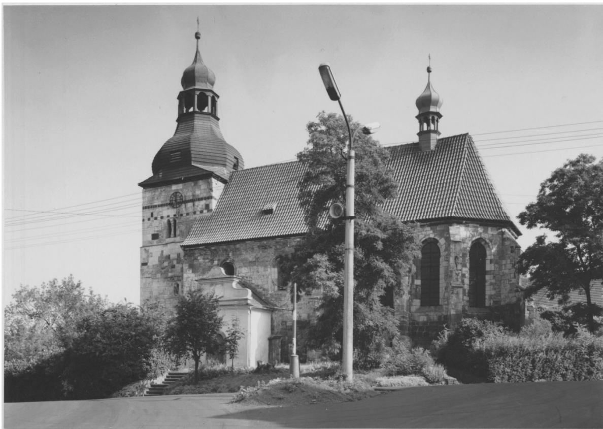
Celkový pohled na kostel od jihu. Foto: 1983, sbírka negativů GŘ NPÚ, sign. N124455.
