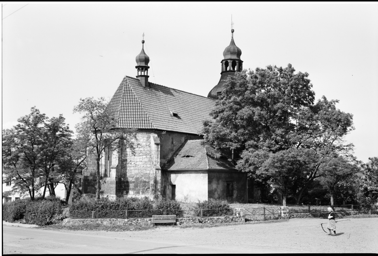
Celkový pohled na kostel od severovýchodu. Foto: 1975, sbírka negativů NPÚ ÚOP v Ústí n. L., sign. 53110.
