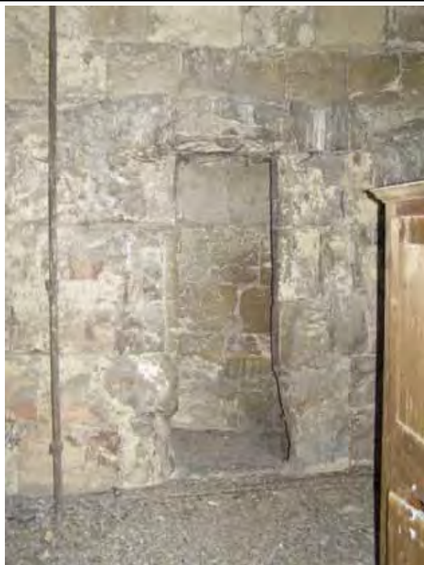
Vstup na schodiště v tloušťce zdi v pohledu od východu z druhého patra věže. Foto: Jan Koloc, 2009.
