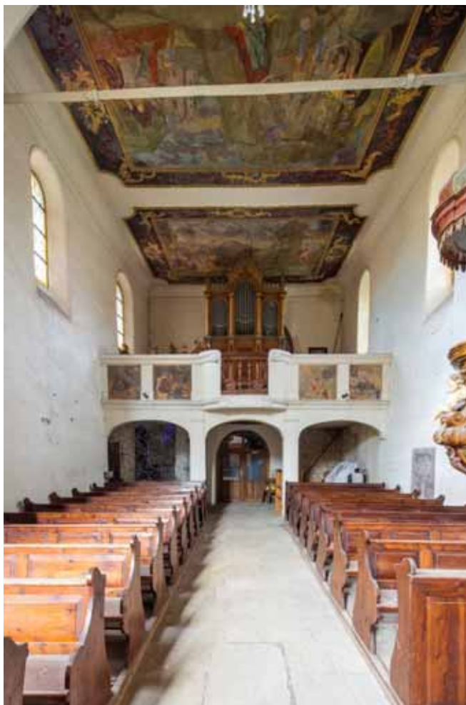
Interiér lodi v pohledu od východu. Foto: Marta Pavlíková, 2014.
