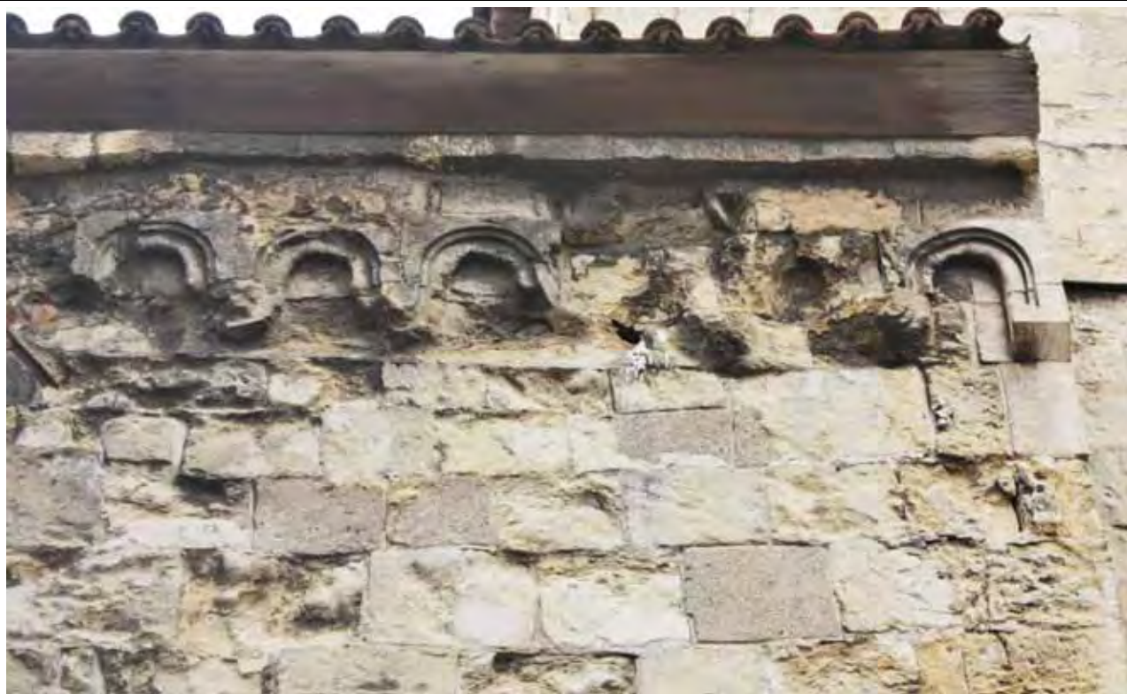
Detail obloučkového vlysu podřímsí na západním konci severního průčelí lodi. Foto: Lucie Radová, 2009.
