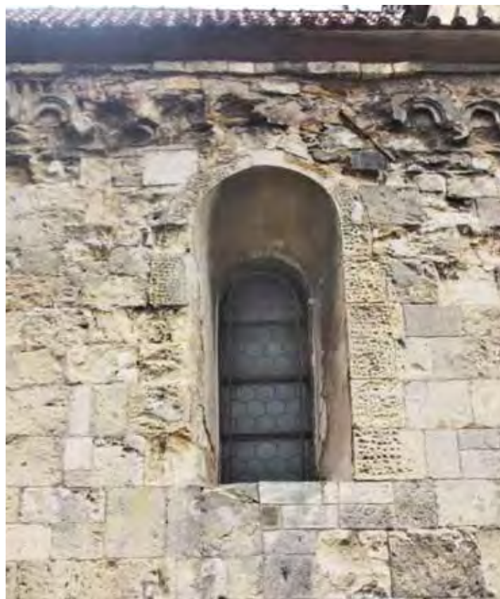
Západní okenní otvor severní strany lodi. Foto: Lucie Radová, 2009.
