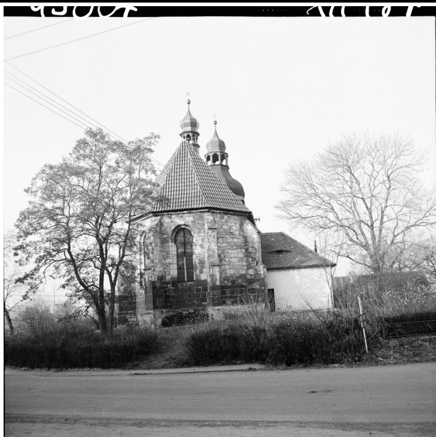
Celkový pohled na kostel od východu. Foto: 1987, sbírka negativů NPÚ ÚOP v Ústí n. L., sign. 95008.
