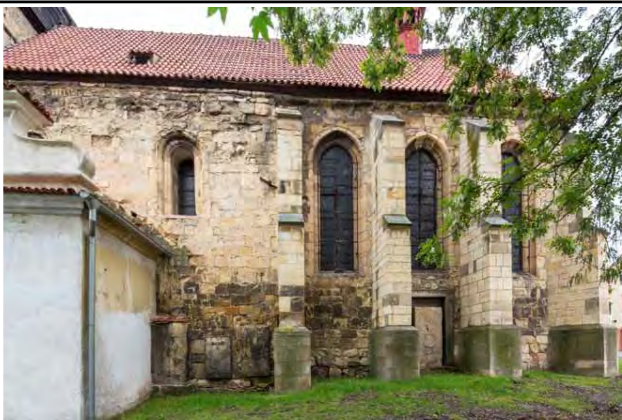
Jižní průčelí lodi a presbytáře v pohledu od jihu. Foto: Marta Pavlíková, 2014.
