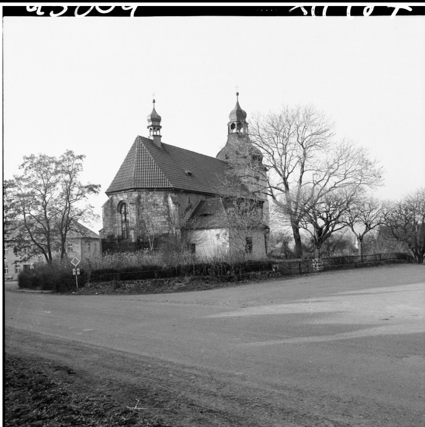
Celkový pohled na kostel od severovýchodu. Foto: 1987, sbírka negativů NPÚ ÚOP v Ústí n. L., sign. 95009.
