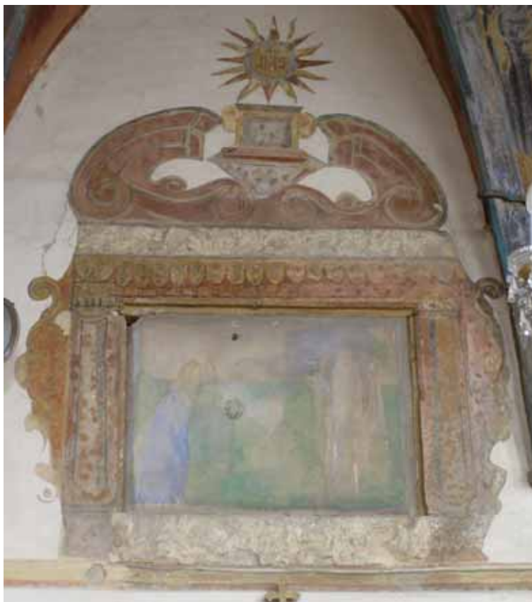
Západní zalděný okenní otvor bývalé oratoře v severní stěně presbytáře. Foto: Jan Koloc, 2009.
