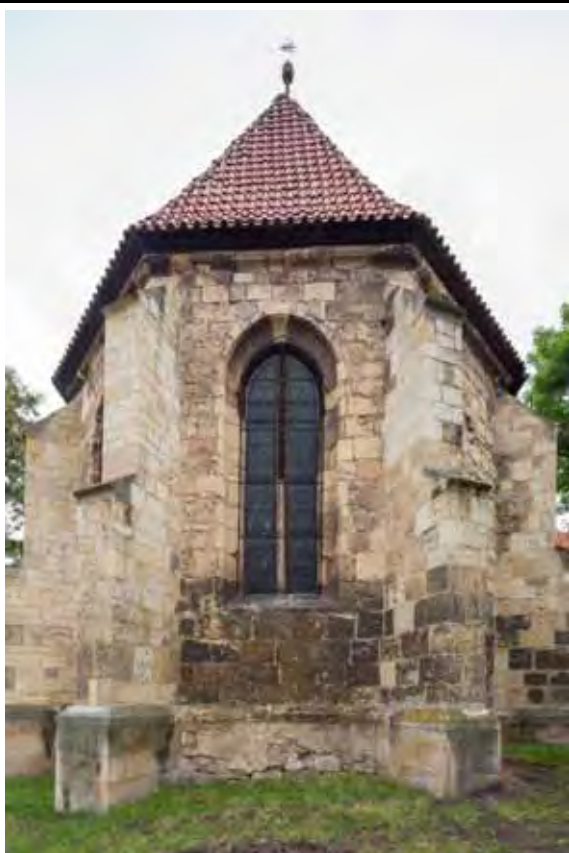
Východní průčelí presbytáře. Foto: Marta Pavlíková, 2014.
